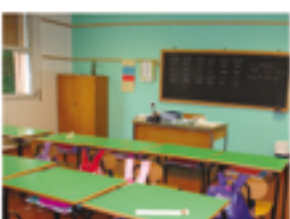
Primaria Anzano, dettaglio lavori
